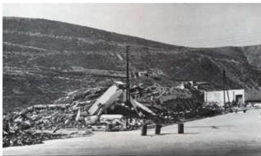
Bâtiment détruit après le séisme
