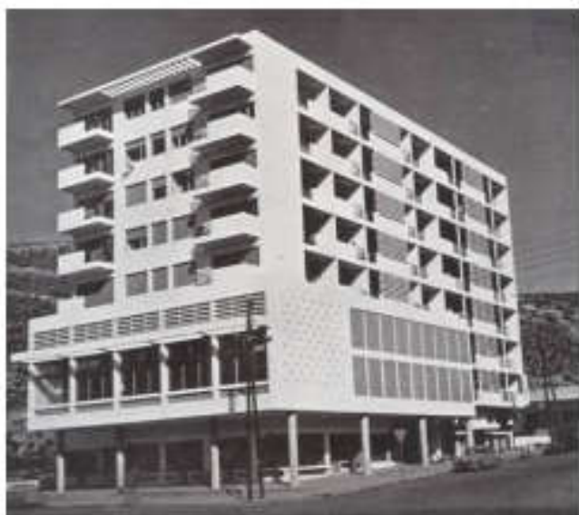
Bâtiment avant le séisme
