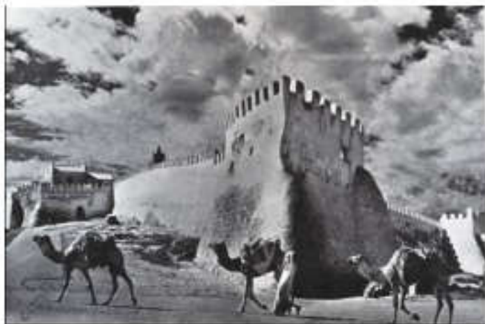
La kasba avant le séisme
