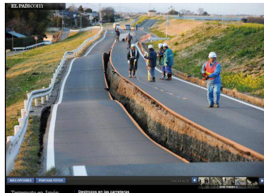
Terremoto en Japón Destrozos en las carreteras
